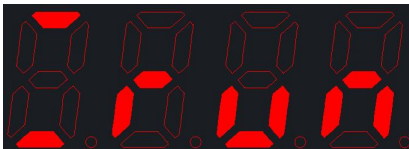
2#水泵运行(不使用互感器)
