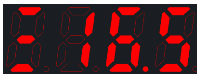
3#水泵电流值 (单位: A)
