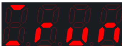
2#水泵运行(不使用互感器)
