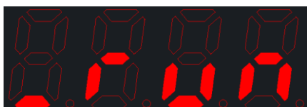
1#水泵运行(不使用互感器)
